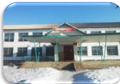
РЕКОНСТРУКЦИЯ МБОУ «АМУРСКАЯ СОШ»
